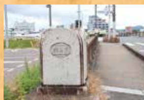
▲ 現在も使用されている片島橋。
