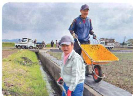
5/11 自治会排水路清掃作業
