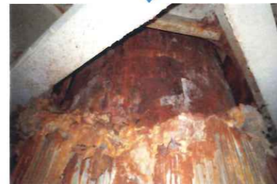
【クリーンセンター】 プラント設備の老朽化
