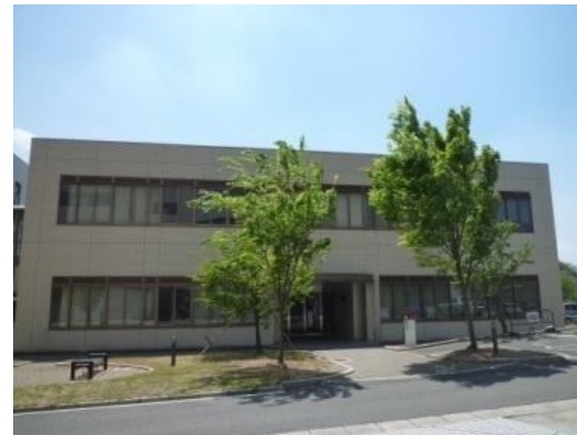
九州工業大学インキュベーション施設（2004）
