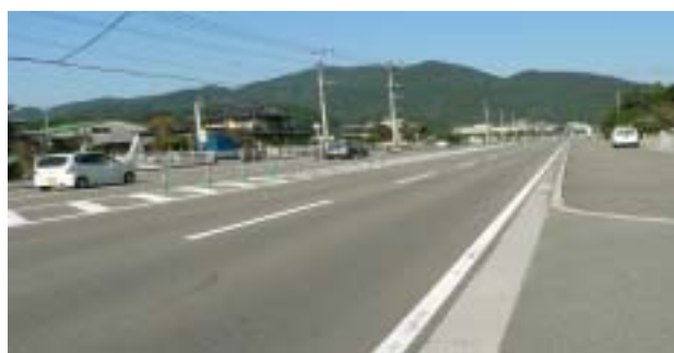
改良された幹線道路（主要地方道飯塚福岡線）
