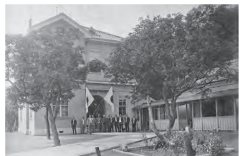
図 2-3-2 竣工時の筑豊石炭鉱業組合 直方会議所
