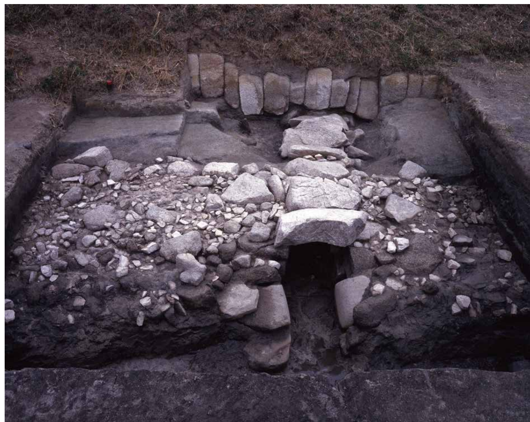
第2暗渠排水口
