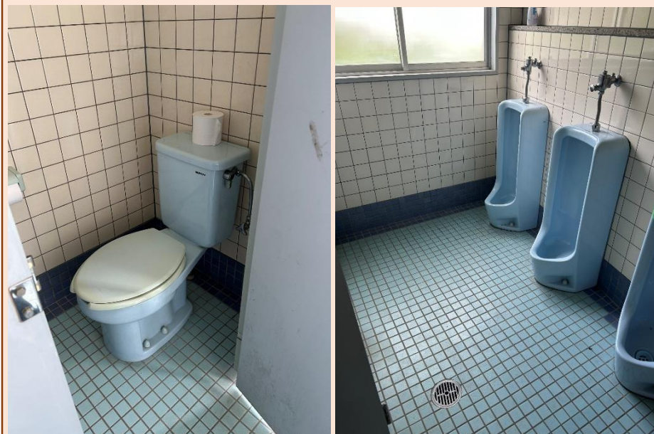
筑穂中学校 多目的室横トイレ
