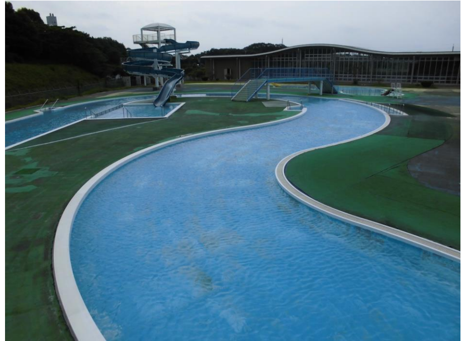
屋外レジャープール
