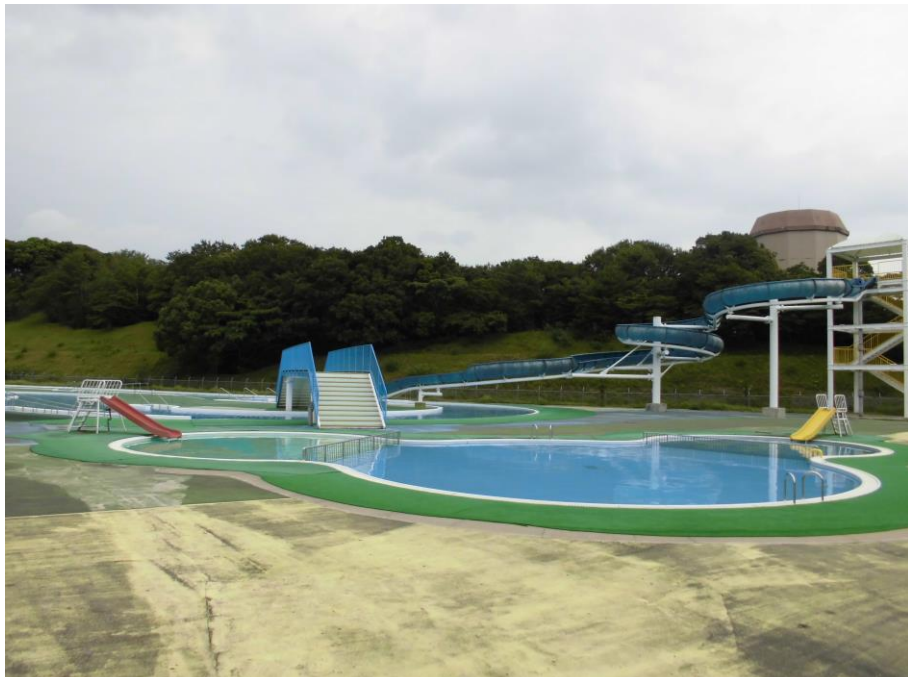
屋外レジャープール
