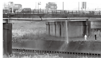
【R2.1 菰田地区漏水事故】
