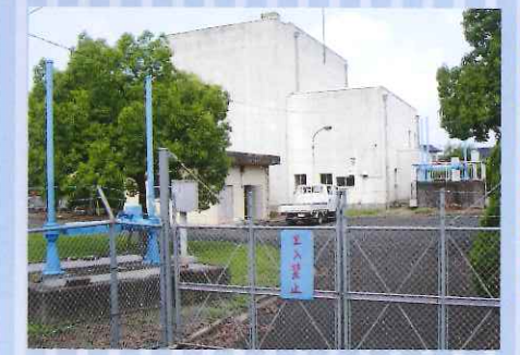
揚水能力:1分に最大1.44m 3 (汚水) 揚水能力:1分に最大471.00m 3 (雨水)
