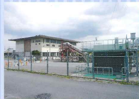
揚水能力:1分に最大57.7m 3 (汚水) 揚水能力:1分に最大608.8m 3 (雨水)
