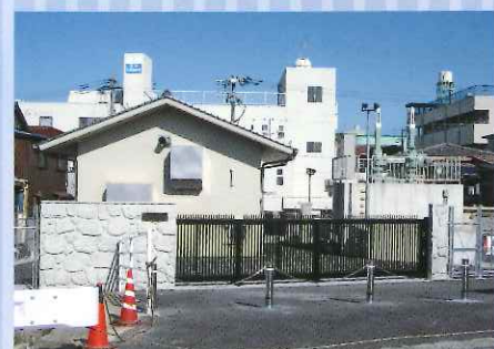
揚水能力:1分に最大132.00m 3 (雨水)
