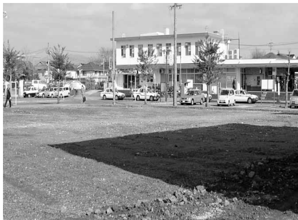
炭都ビル解体後
