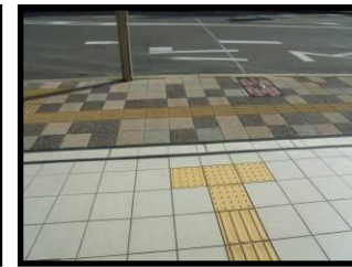
(点字ブロックが途切れているため入口がわからない)
