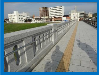
(芳雄橋の歩道が広く通りやすかった、欄干に手すりがある)
