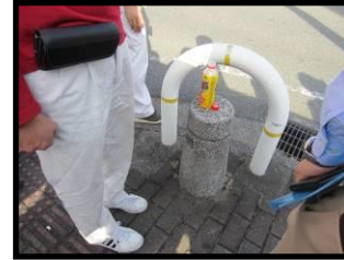
(菰田西交差点歩道の車止めが膝より高く、ぶつかりやすい)
