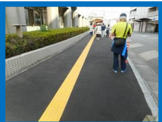
(新しく舗装された道には、最新の点字ブロックが設置されており見やすい)
