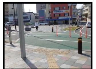
(点字ブロックが直角に交わっておらず、どちらに進めば真っ直ぐなのかわからない)
