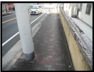
(歩道に電柱があり危険)
