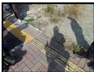
(歩道にある点字ブロック(古いタイプ)の劣化)
