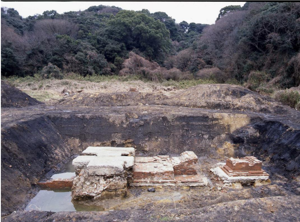
平成 23 年度調査 コンクリート蓋 煉瓦積凸形状台座 煉瓦積方形台座
