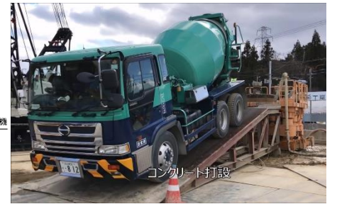
▲生コン打設状況
