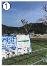
インクルーシブ公園の 工事中です
