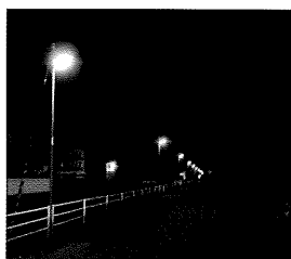
市内の防犯灯約1400基のLED化が実現！
