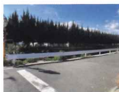
伊川南風堂付近 (ガードレール設置)
