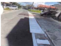
穎田口春付近 (側溝の蓋改修)
