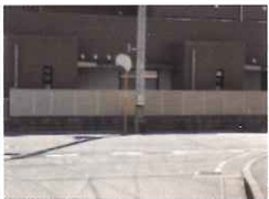
相田くぬぎ苑付近 (カーブミラー設置)
