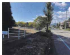
飯塚市環境センター付 近(ガードパイプ設置)
