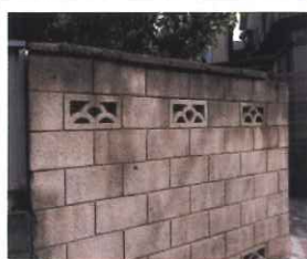
危険なブロック塀の撤去費用の一部補助金実現！
