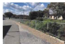
目尾団地敷地内 (フェンス改修)
