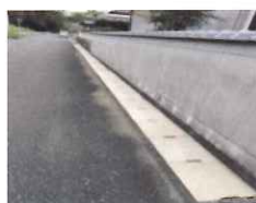
柳橋グリーンハイツ内 (側溝の蓋設置)
