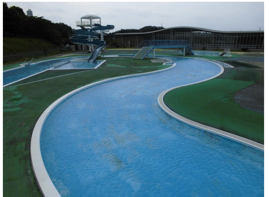
屋外レジャープール
