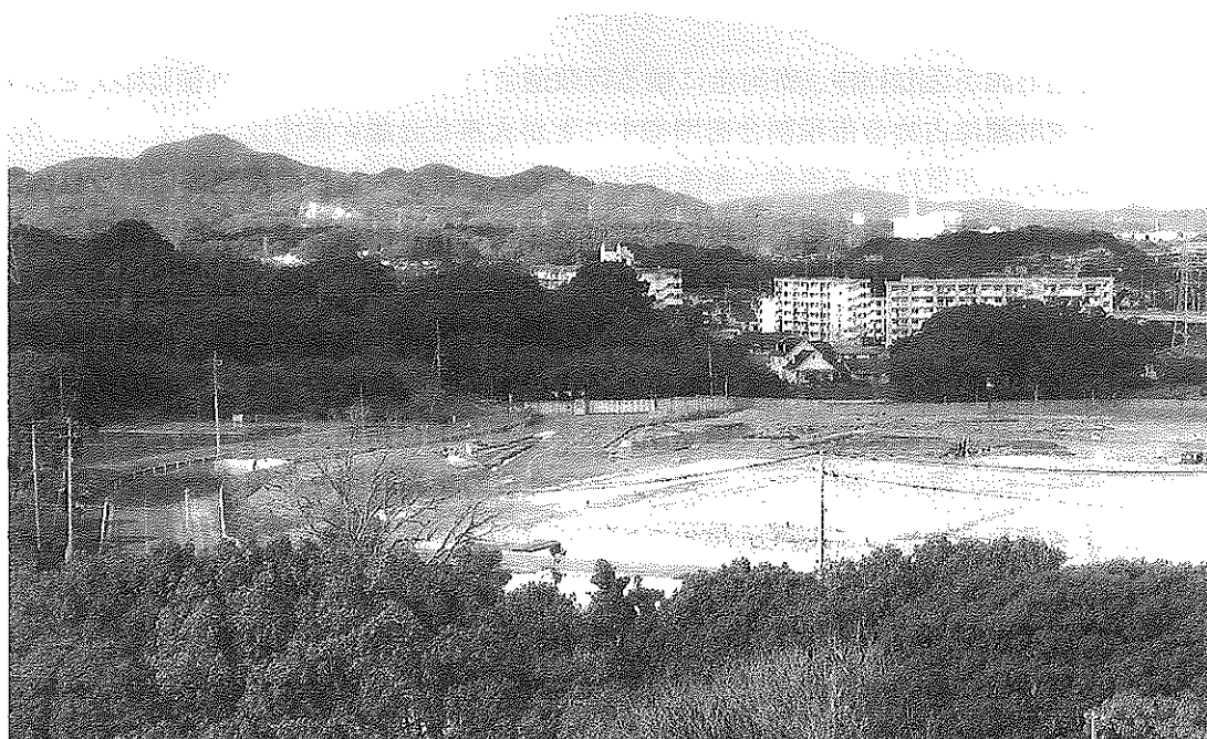
(工事が一時中断した新体育館建設用地と周辺風景)
